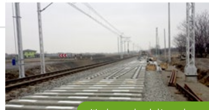
Wymiana nawierzchni torowej
